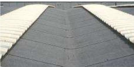
Grazie all’impiego di pannelli micromorph, che non necessitano dell’orientamento a 30° verso lo zenit, è ora possibile utilizzare tutta la superficie utile dei tegoli e del muretto perimetrale (identificati nella sezione in arancione) migliorando così la protezione, l’isolamento termico e l’impermeabilizzazione di questi con la sola esclusione del vano montacarichi. La superficie utile è quindi stimata in un totale di ca. 1.000 mq.
