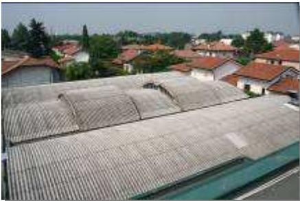
base, è suddivisa in tre sezioni a volta cilindrica ribassata in laterizi autoportanti tipo STAR (identificati nella sezione in giallo) con tiranti metallici reggispinta isolati termicamente, sulle quali non insistono impedimenti, fuorché sulla volta centrale, ove le sopraelevazioni per i lucernari (identificati nella sezione in arancione) non comportano ombreggiamenti sostanziali ai fini dell'irraggiamento dei pannelli.
