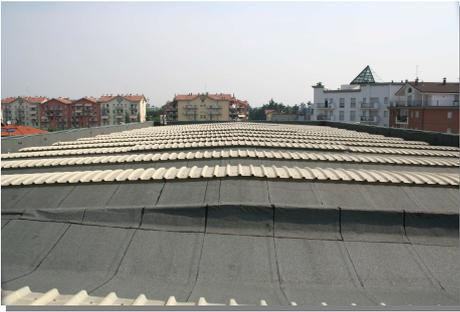
Il tetto “semi piano” dello stabile adibito a magazzino è realizzato con sistema a tegole ALBATROS 308 (identificati nella sezione in giallo), costituito da un pannello di polistirene protetto da uno strato di calcestruzzo fibroarmato.
