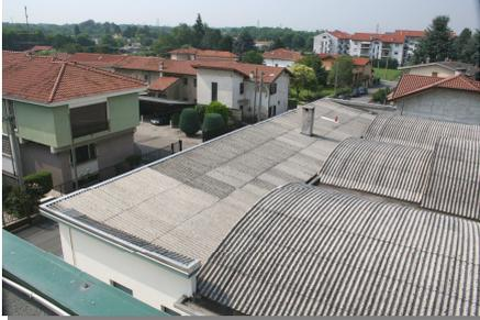
ca. 210 mq. La copertura a tetto ad unica falda con orditura portante in legno (identificati nella sezione in giallo) fornisce l'inclinazione necessaria all'evacuazione delle acque di pioggia. Questa è successivamente ricoperta
